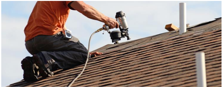
Reparaciones de Vivienda
